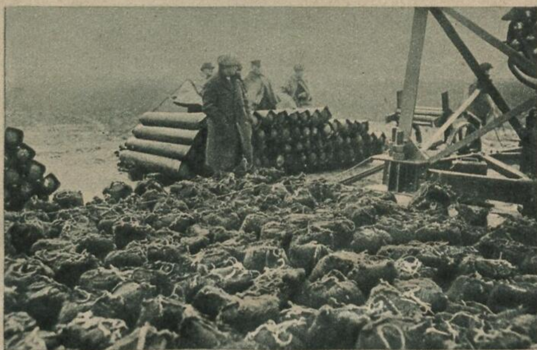
Auch das Luftschiff will nach anstrengender Reise neue „Nahrung“ haben: Sandsäcke im Gewicht von 3000 Kilogramm als Ballast und Stahlflaschen mit Gas am Landungsplatz Fotoaktuell
