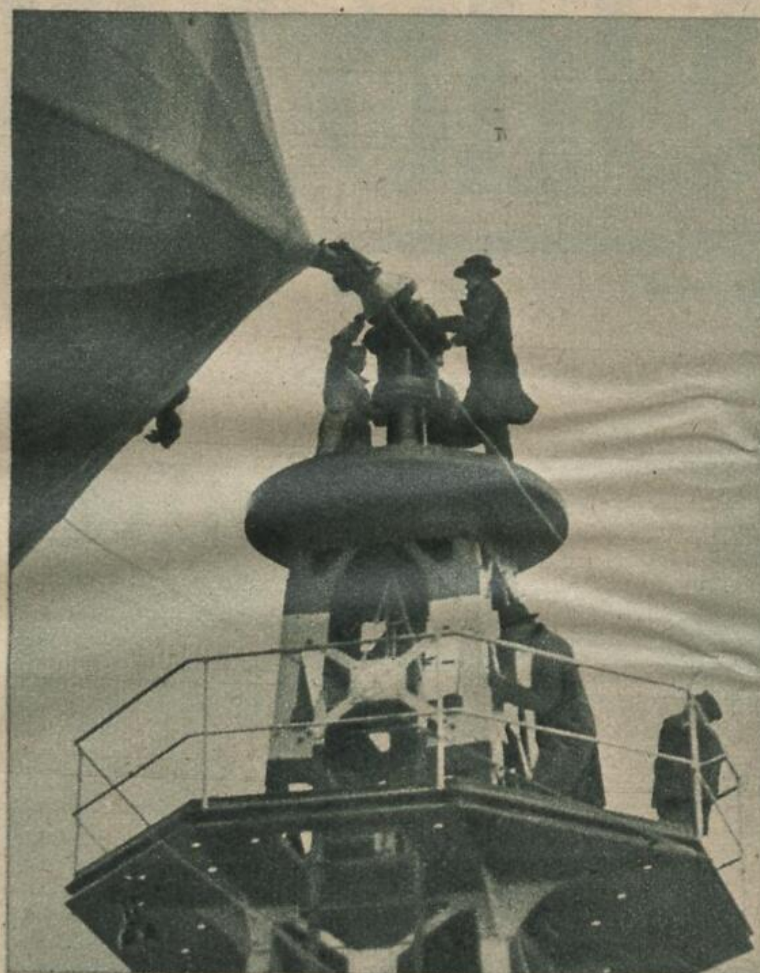
← Bild links: Das Heck des Luftschiffes ruht auf dem Boden, und zwar ist die hintere Motorengondel auf einem Fahrgestell befestigt. Die Räder des Gestelles laufen auf einem Kreise, so daß sich das Luftschiff am Ankermast im Winde bewegen kann Fotoaktuell Bild unten: Wie eine mit dem Zeppelin beförderte Postsendung aussteigt. — Eine vom Leipziger Messeamt nach Amerika mit „L. Z. 127“ gesandte Luftpostkarte
