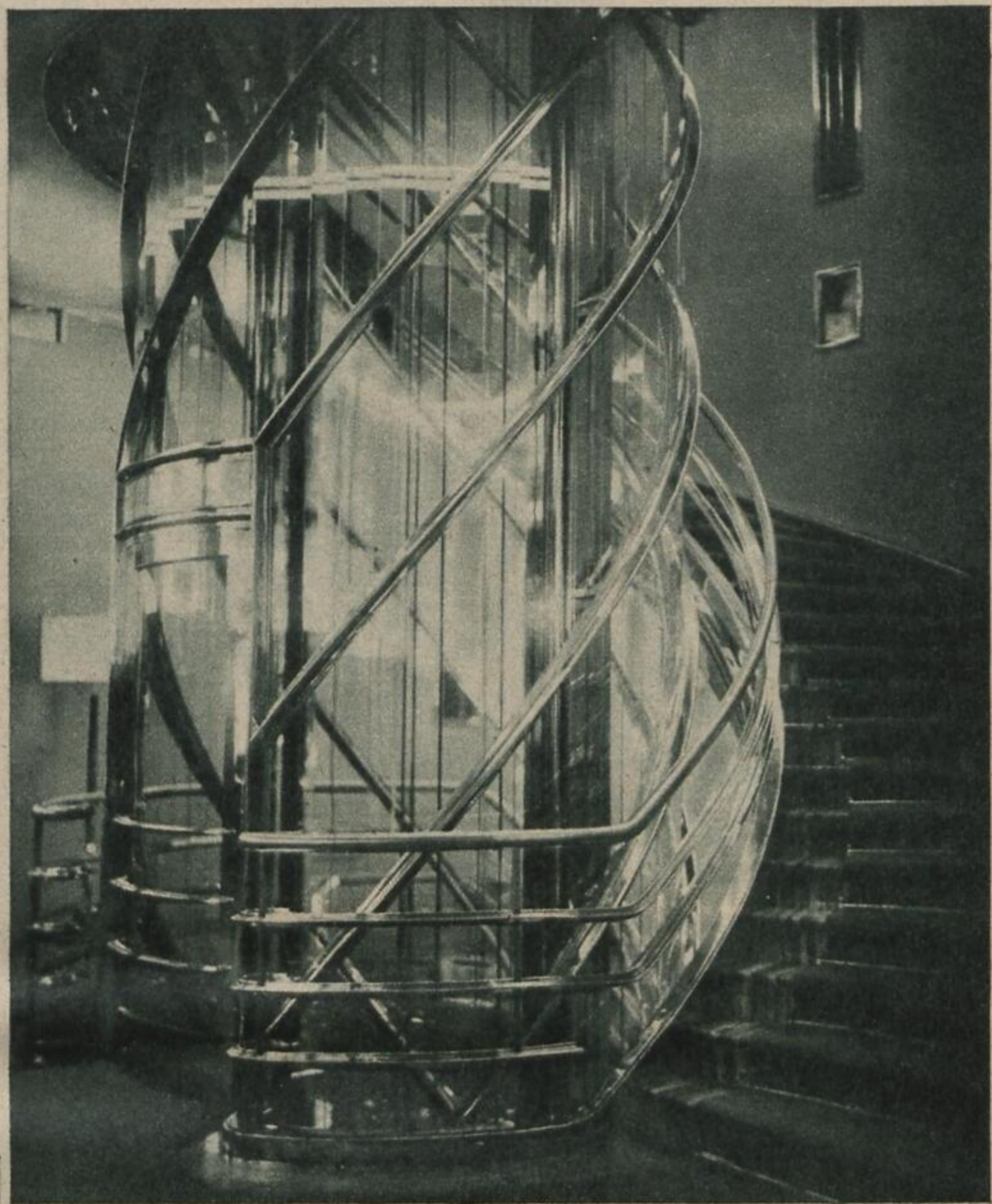
↑ Bild oben: Nur aus Glas und Stahl wurde das Treppenhaus eines großstädtischen Warenhauses hergestellt. Das Material kommt bei der zweckmäßigen Architektur wirkungsvoll zur Geltung. — Am Fahrstuhl des Warenhauses Willott, Berlin
