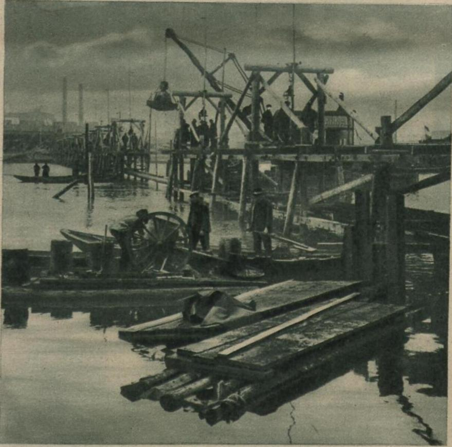
← Bild links: Verlegen von Gasleitungsrohren durch den Main. Offenbach soll in Zukunft von Frankfurt am Main versorgt werden; dazu mußten zwei neue Rohrleitungen von je 30 Zentimeter Durchmesser durch den Fluß verlegt werden Jäger, Frankfurt am Main
