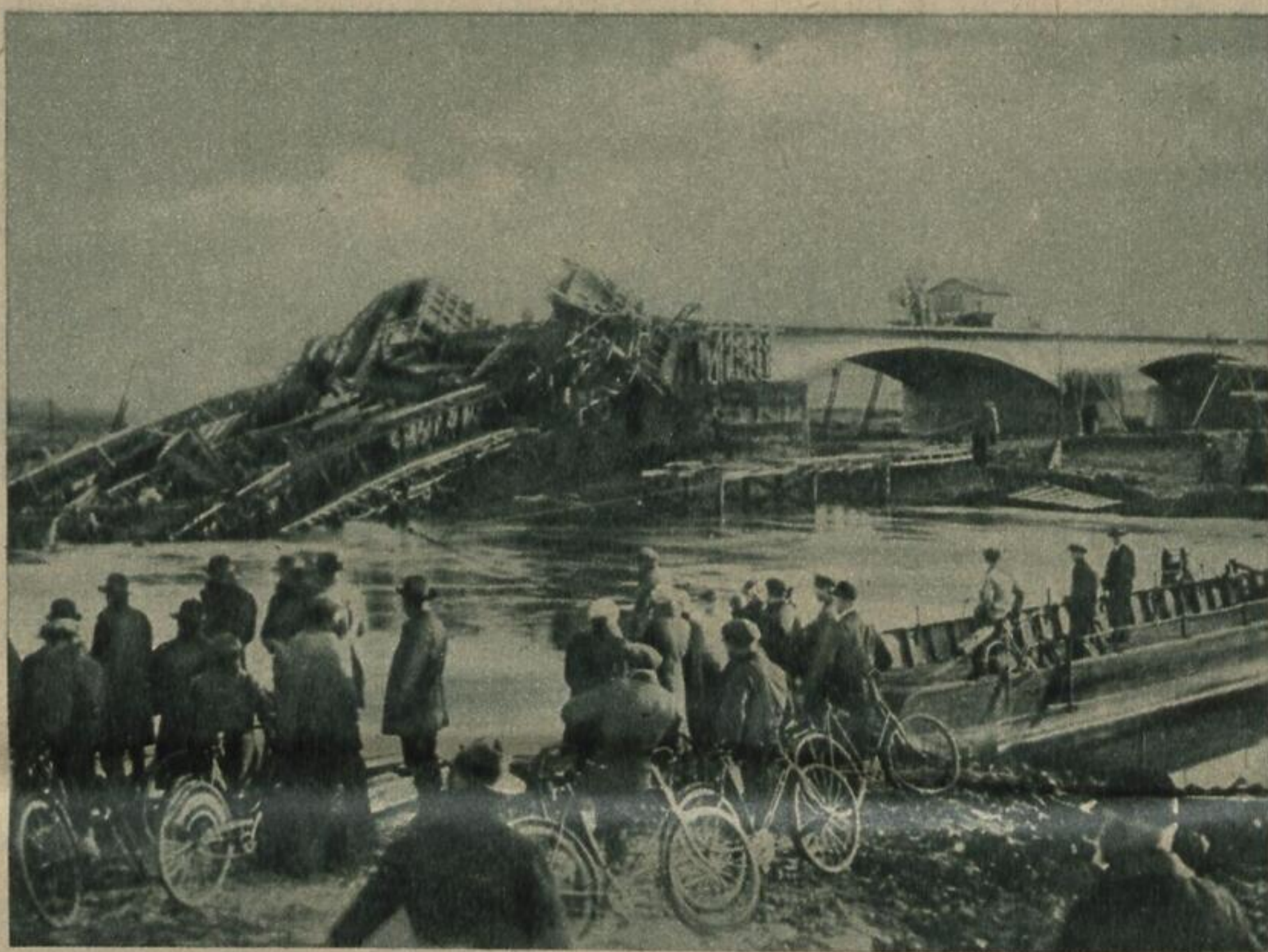
Der Neubau einer Betonbrücke über die Sieg in der Nähe von Troisdorf stürzte ein. Ein Arbeiter wurde getötet, fünf weitere schwer verletzt. Die Brücke liegt im Zuge einer neuen Autostraße Welt-Photo
