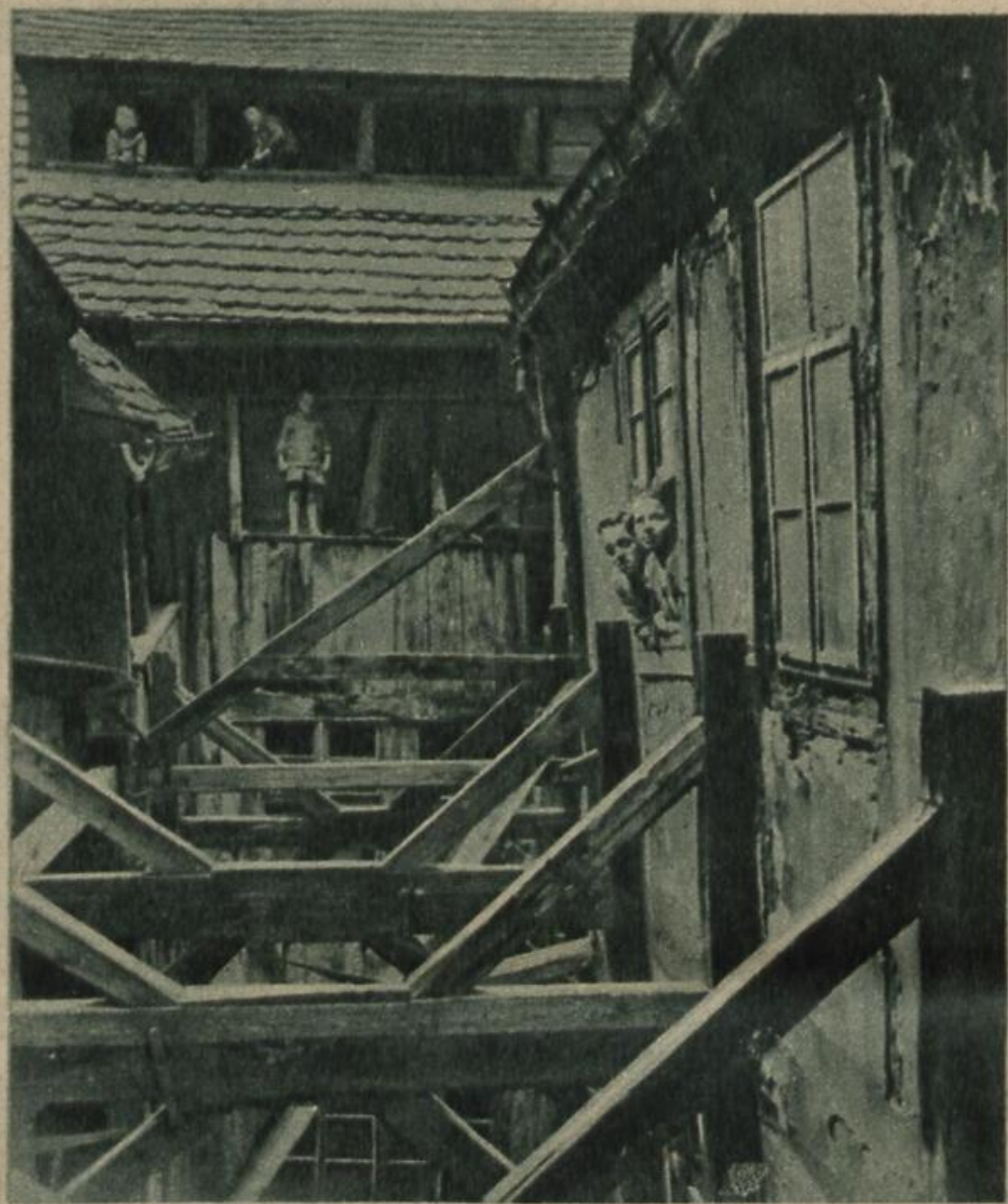
Die ältesten Häuser der Stadt Dresden in der über 400-jährigen Zwingerstraße drohen einzustürzen. Die unmittelbare Gefahr ist vorläufig durch Abstützen mit Balken hinausgeschoben Grosf
