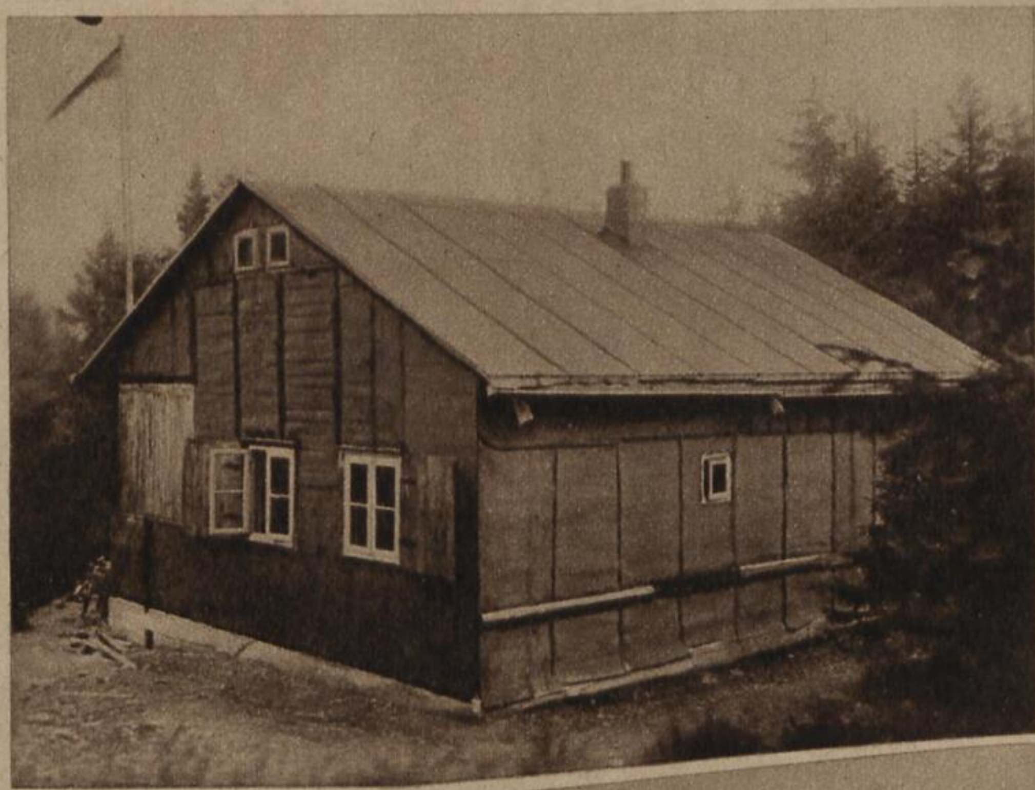
Das Damnhaus bei Osterode im Harz, eine von der Schneeschuhgilde Osterode erst im November erbaute Schuhhütte, die von Wintersportlern jetzt rege beansprucht wird
