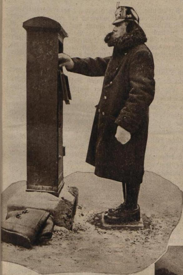
Der Verkehrspolizist auf der Wärmeplatte, ein neues Bild in den verkehrreichen Großstadtstraßen während der Kälteperiode. Vor dem mit der Hand zu betätigenden Licht- signalapparat ist eine Standplatte eingelassen, die elektrisch geheizt wird
