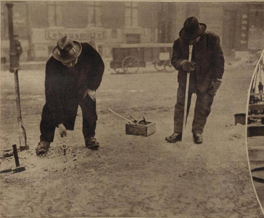
„Die Gaschnüßler“. Zur Kontrolle der infolge der starken Kälte vielfach beschädigten Gasrohre sind jetzt Gasriecherkolonnen organisiert, um die Leitungen zu prüfen. Geheimnisvoll sieht sich ihr Walten an, wenn sie die langen Rohre in die Erde stecken und an der oberen Öffnung riechen Kestone
