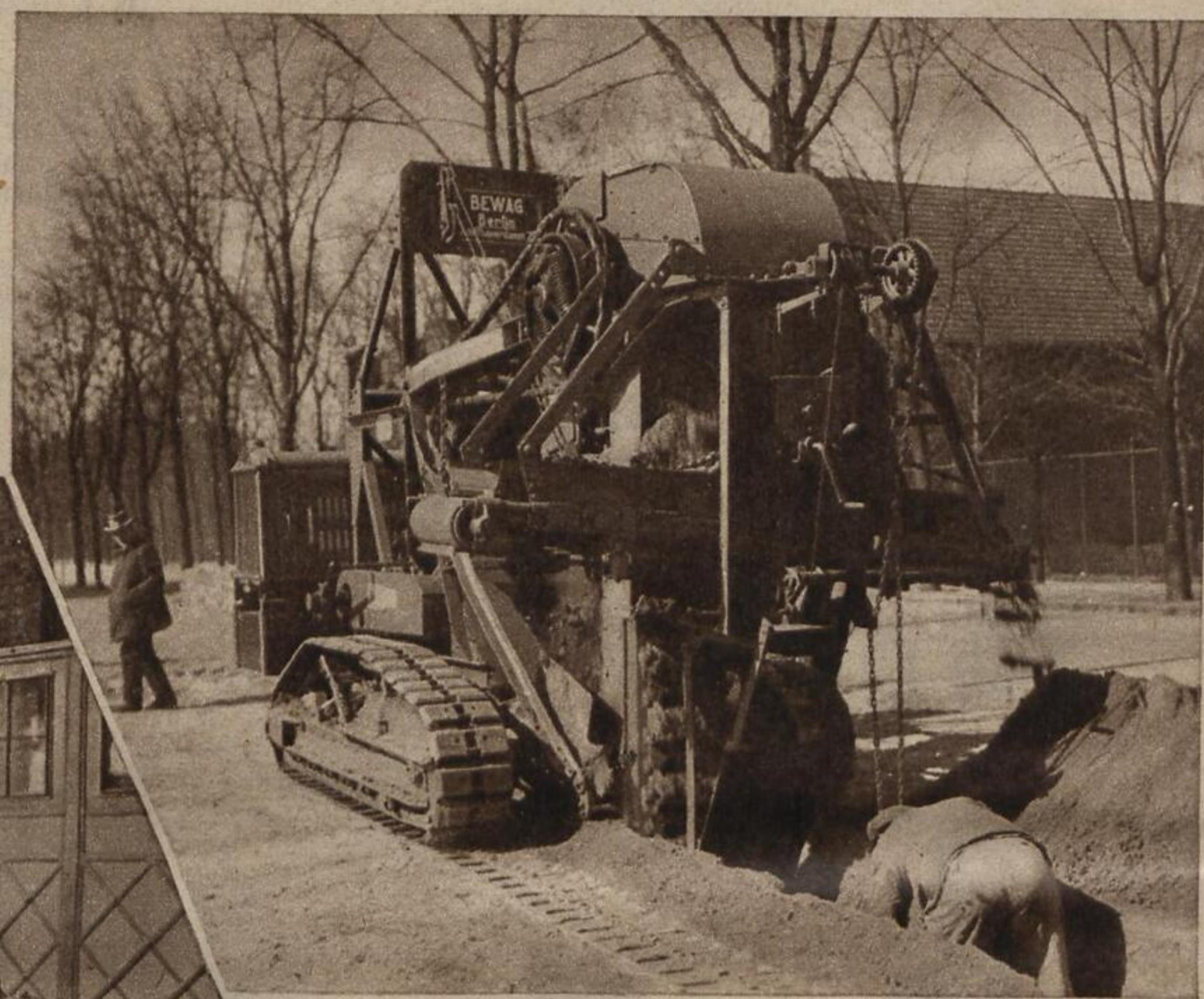
Einen Graben von 100 Meter in der Stunde wirft eine Maschine aus, die zum Verlegen von Kabeln benutzt wird. Der Graben ist je nach Einstellung einen halben bis einen Meter tief
