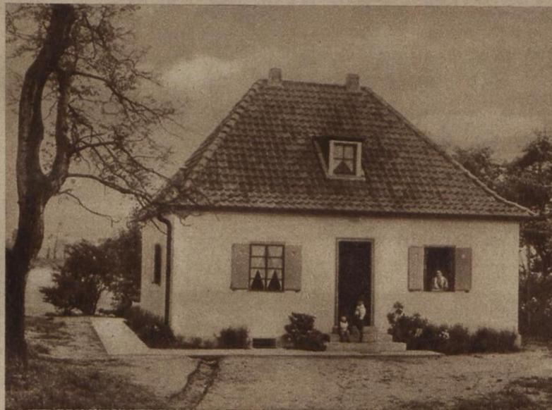
Bild unten: Stahlrahmenhaus. Die Wände zeigen aus Stahlblech gepresste und genormte Leichtprofile, die die tragenden Funktionen ähnlich wie bei einem Fachwerkbau übernehmen. Zwischen den Rahmen werden die Wände mit Hilfe von Streckmetall und Leichtbetonplatten ausgefüllt
