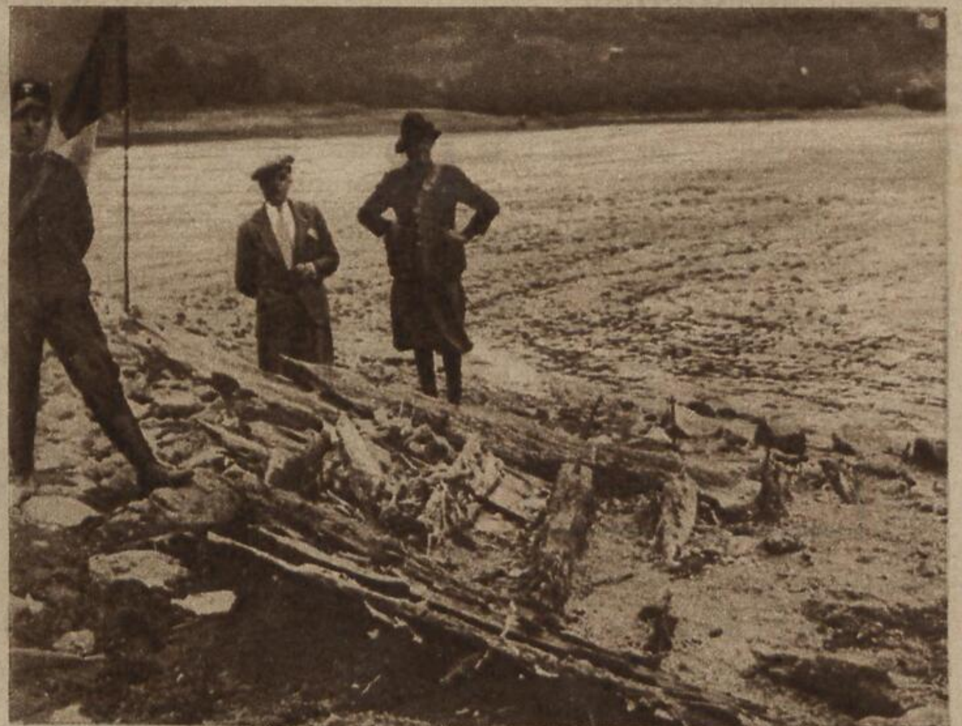
Das erste der Brunnenschiffe des Kaisers Caligula ist infolge der Pumparbeiten am Nemiser, über die wir bereits berichteten, aus dem Wasser aufgetaucht. Italienisches Militär sperrt die Umgebung dem Zutritt Neugieriger P. & A.-Photos
