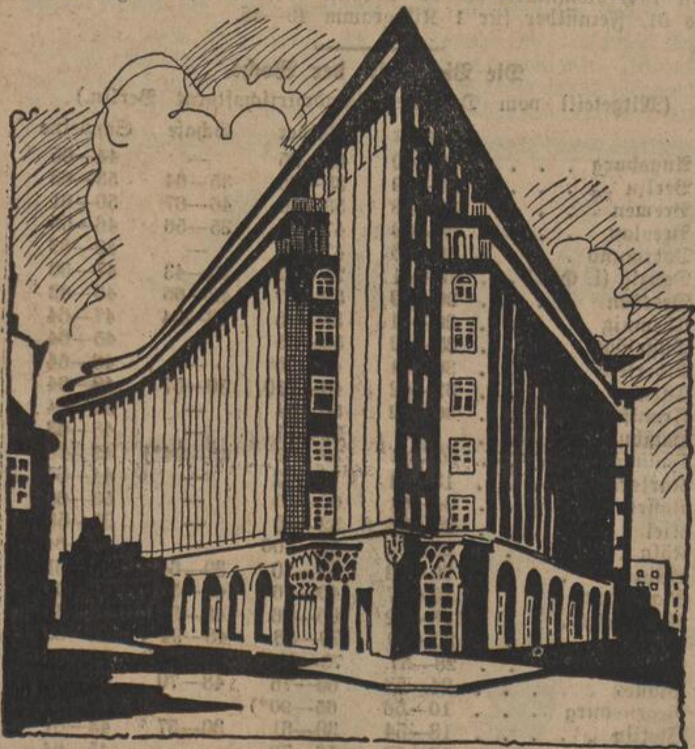
Das Chilehaus, einer der großen Kontorpaläste in Hamburg.
