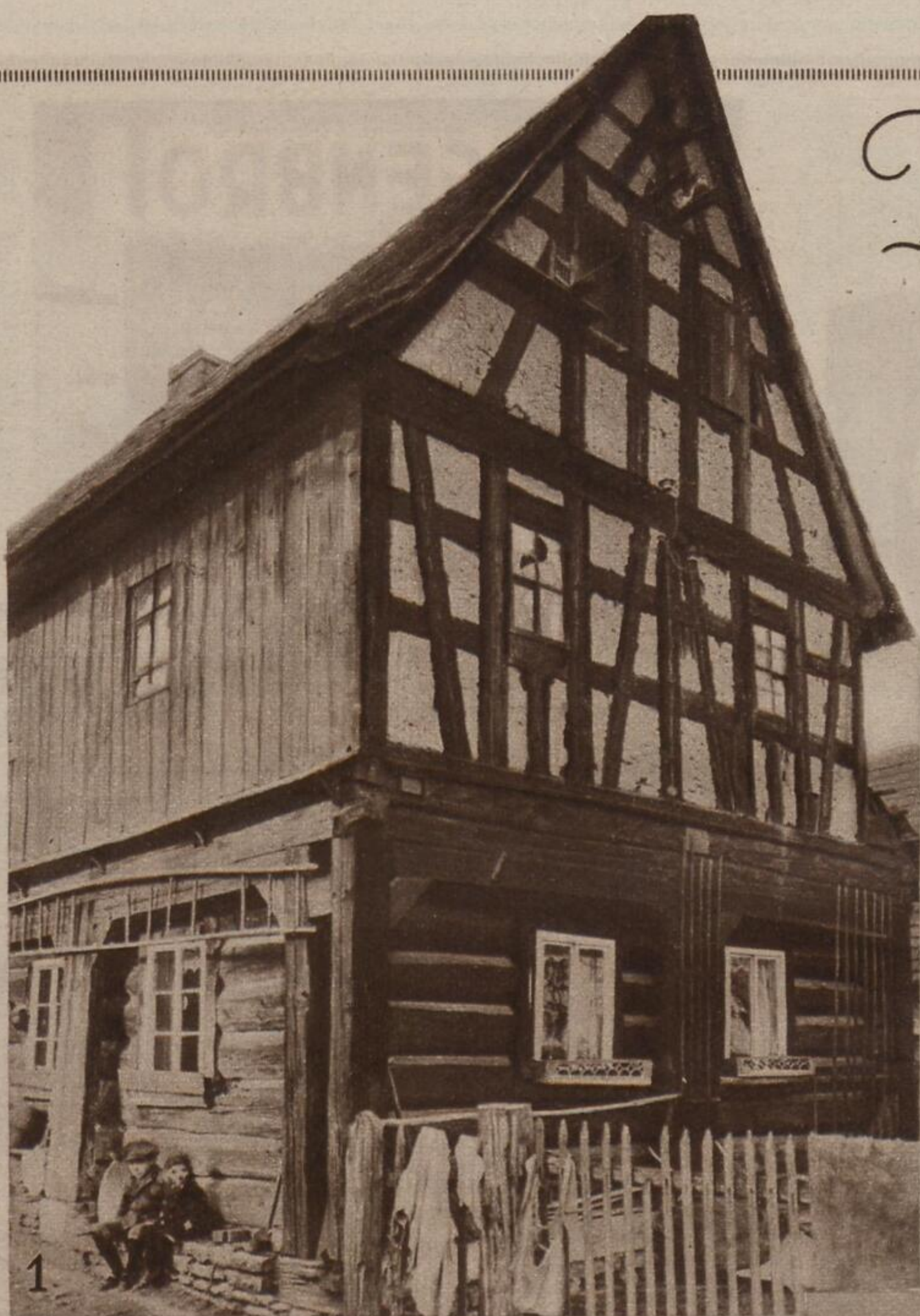
Bild links: In Hartmannsdorf bei Gera. Ein ostthüringisches Bauernhaus, 1737. Hinter dem „Bohlenstuhl“ stehen im Erdgeschoss Bohlenwände, während darüber lehmausgestattetes Fachwerk entwickelt ist.
