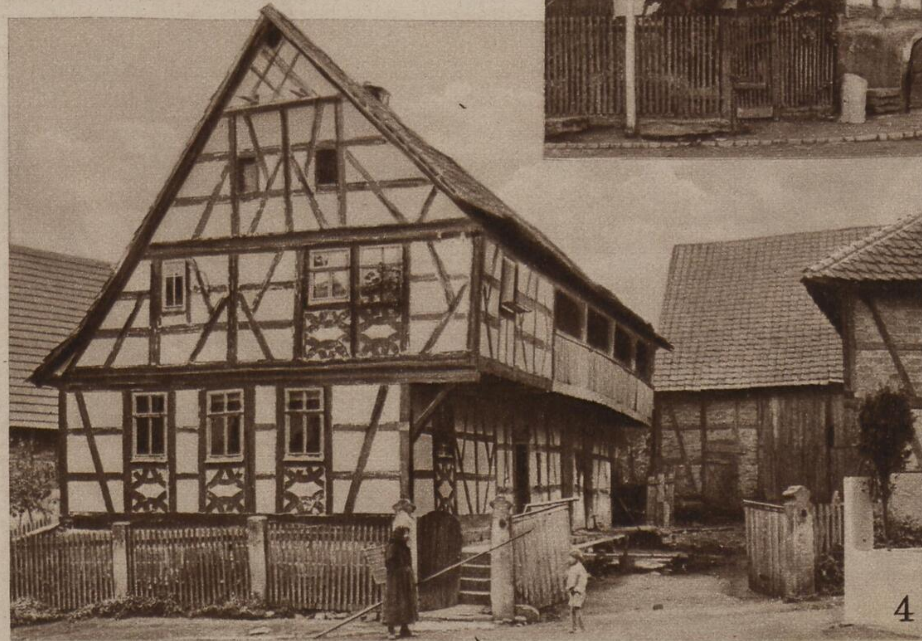
In Zimmershausen, Kreis Hildburghausen, 18. Jahrhundert. — Hier ist eine Gästestube im Dachgeschoss vermittels eines Zwerchhauses (Querschiffes) eingebaut. Unter dem „Scheppdach“ ist wiederum eine Treppenlaube. Im Hintergrund die Hofscheune.
