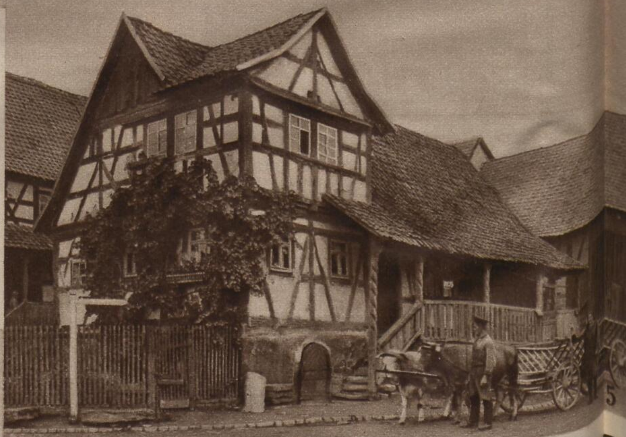
In Zimmershausen, Kreis Hildburghausen, 18. Jahrhundert. — Hier ist eine Gästestube im Dachgeschoss vermittels eines Zwerchhauses (Querschiffes) eingebaut. Unter dem „Scheppdach“ ist wiederum eine Treppenlaube. Im Hintergrund die Hofscheune.
