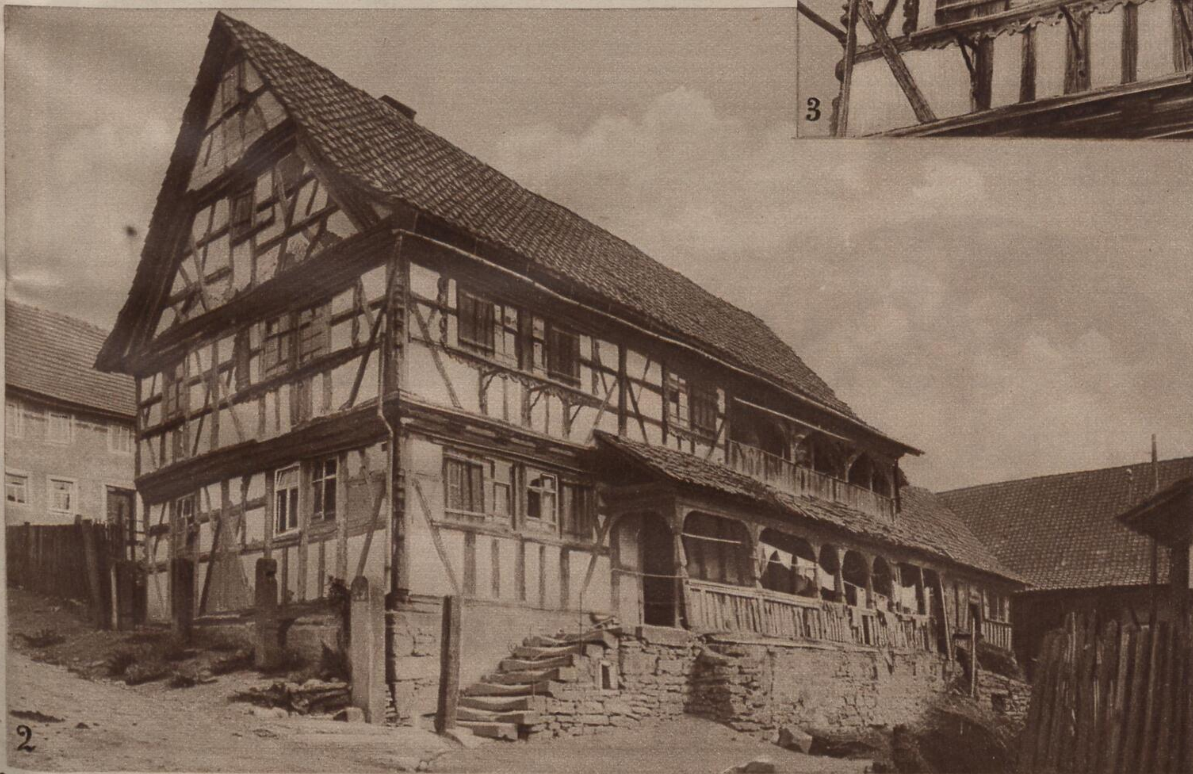
In Westfeld bei Römheld. Ein südthüringisches Bauernhaus, 1766 erbaut. An der vorderen Ecke sind die vier Fenster der Bauernstube zu sehen, darüber die bleiverglaste Fenster der Gästestube. Kennzeichnend ist die überdachte Treppenlaube an der Traufenfront. Hinten die Hofscheune. — Das kleine Bild oben rechts gibt nochmals vergrößert die Schiebläden in kunstvoll durchbrochenen Holzrahmen vor den bleiverglaste Schiebefenstern wieder
