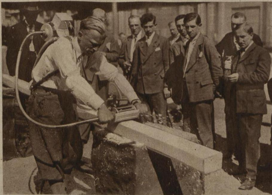
← Bild links: **Bei der Vorführung einer handlichen Sobelmaschine mit Elektroantrieb,** deren Motor auf dem Rücken getragen wird; sie ist infolge der Leichtigkeit ihres Transportes besonders praktisch und vielseitig verwendbar
