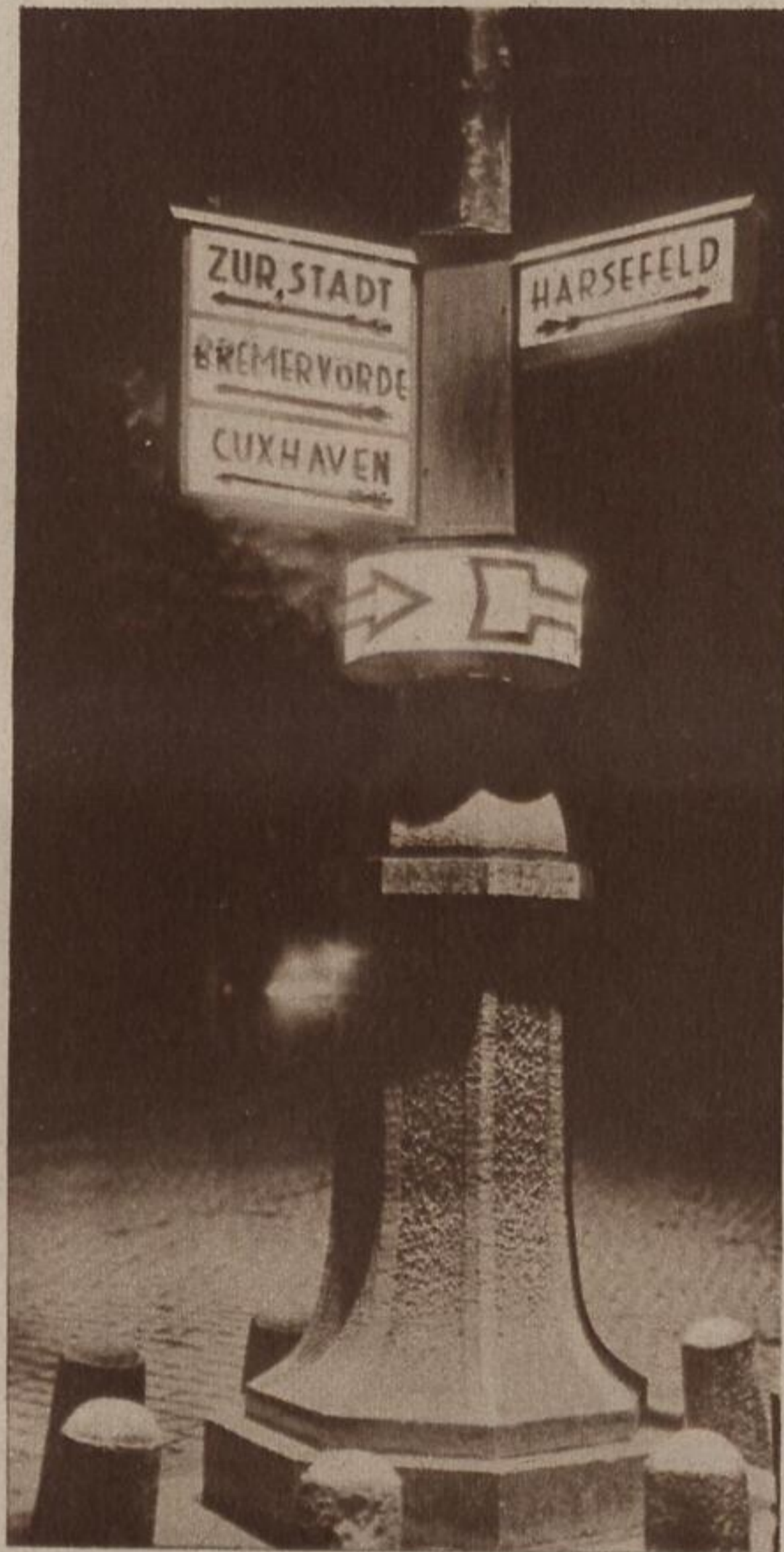
Eine nachahmenswerte Neuerung, die die Stadt Stade in Hannover einführt: Die Wegweiser an den Straßenkreuzungen sind Transparente, die nachts erleuchtet werden Atlantic
