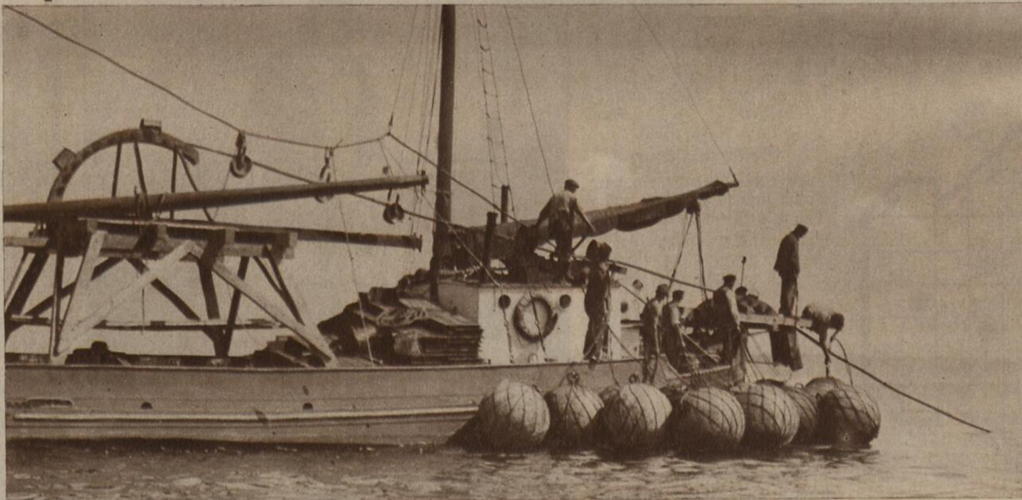
Das Seekabel läuft über die Seetrolle von dem Verlegedampfer hinab ins Meer
