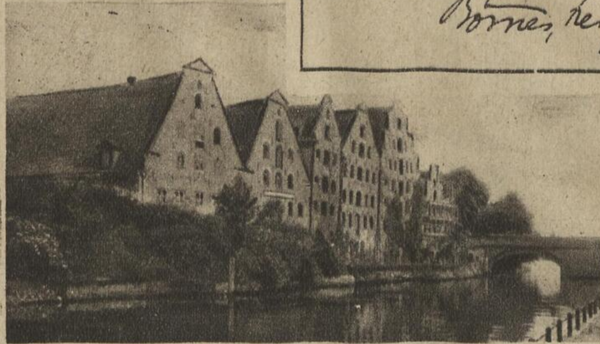
Photothek Die Lübecker Salzspeicher am Holstentor, ein altes Wahrzeichen Lübecks, sind in ihrem Bestande gefährdet. Jetzt ist wenigstens der erste wiederhergestellt worden
