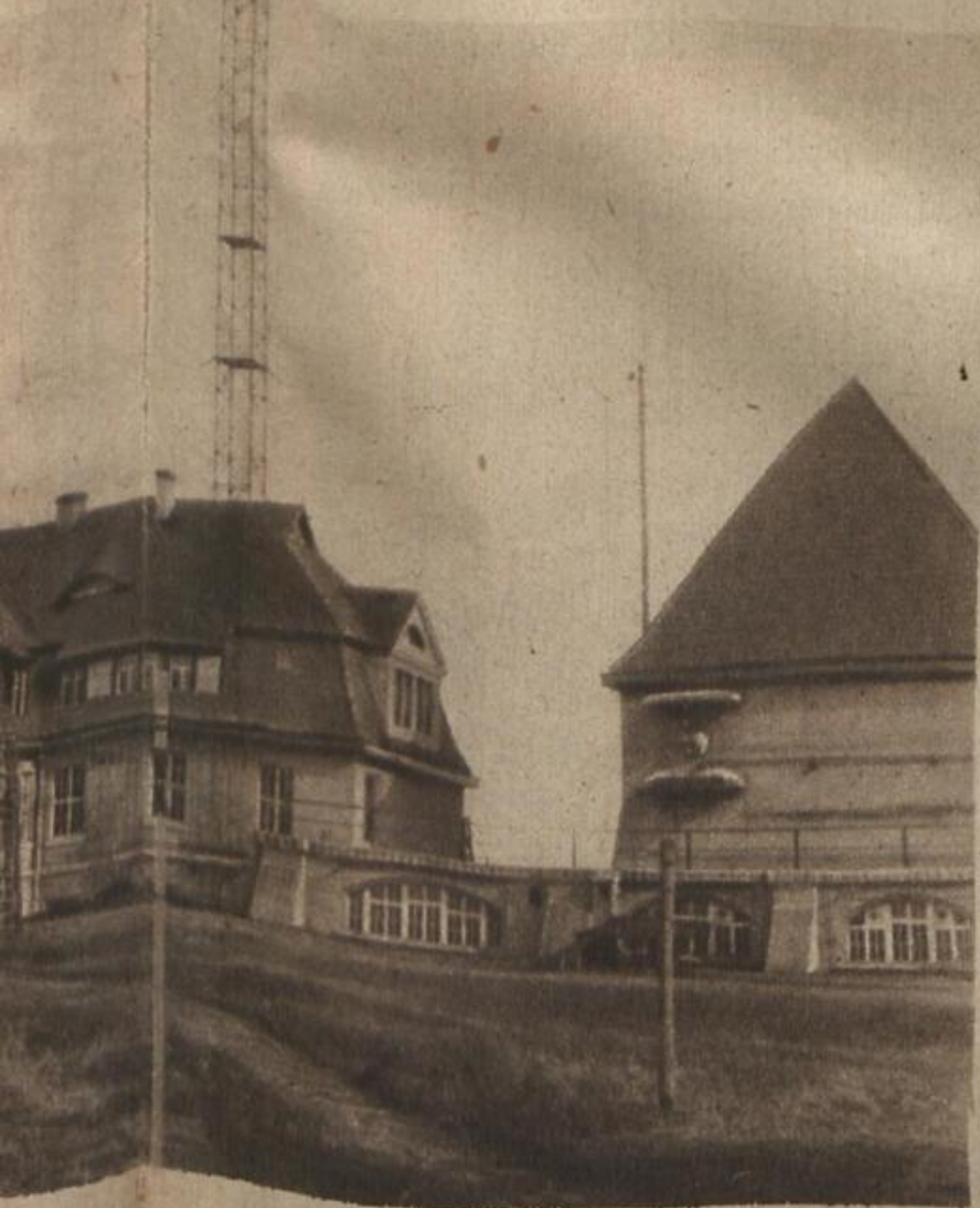
Verwaltungsgebäude und Maschinenkeller
