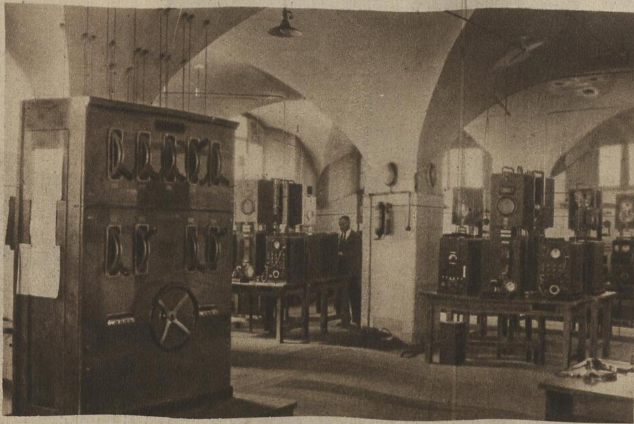
Blick auf das Inlandsfunknetz (500-Watt-Röhrensender). Links der Antennenschalter für die großen Sender
