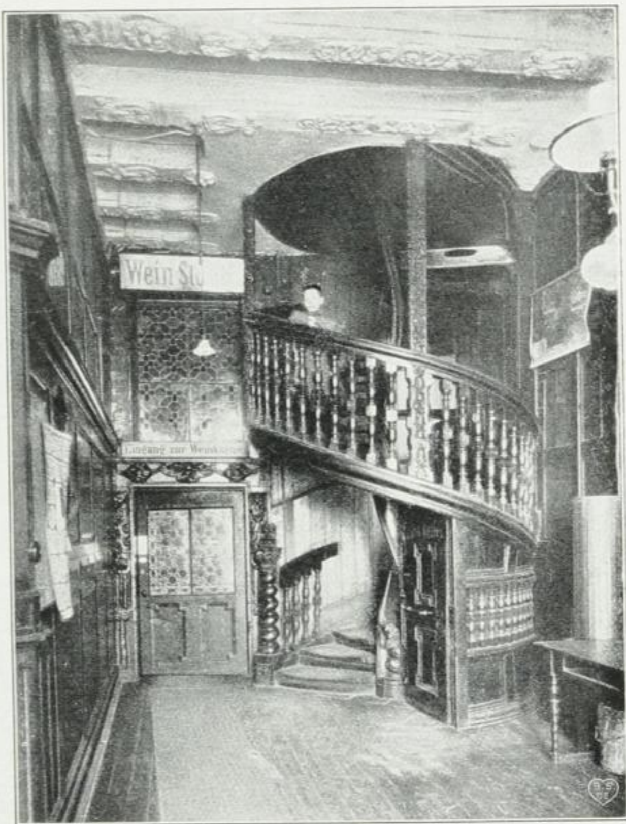
Fig. 151. Diele mit Wendeltreppe im Haus zur Glocke am Hof, 1695.
