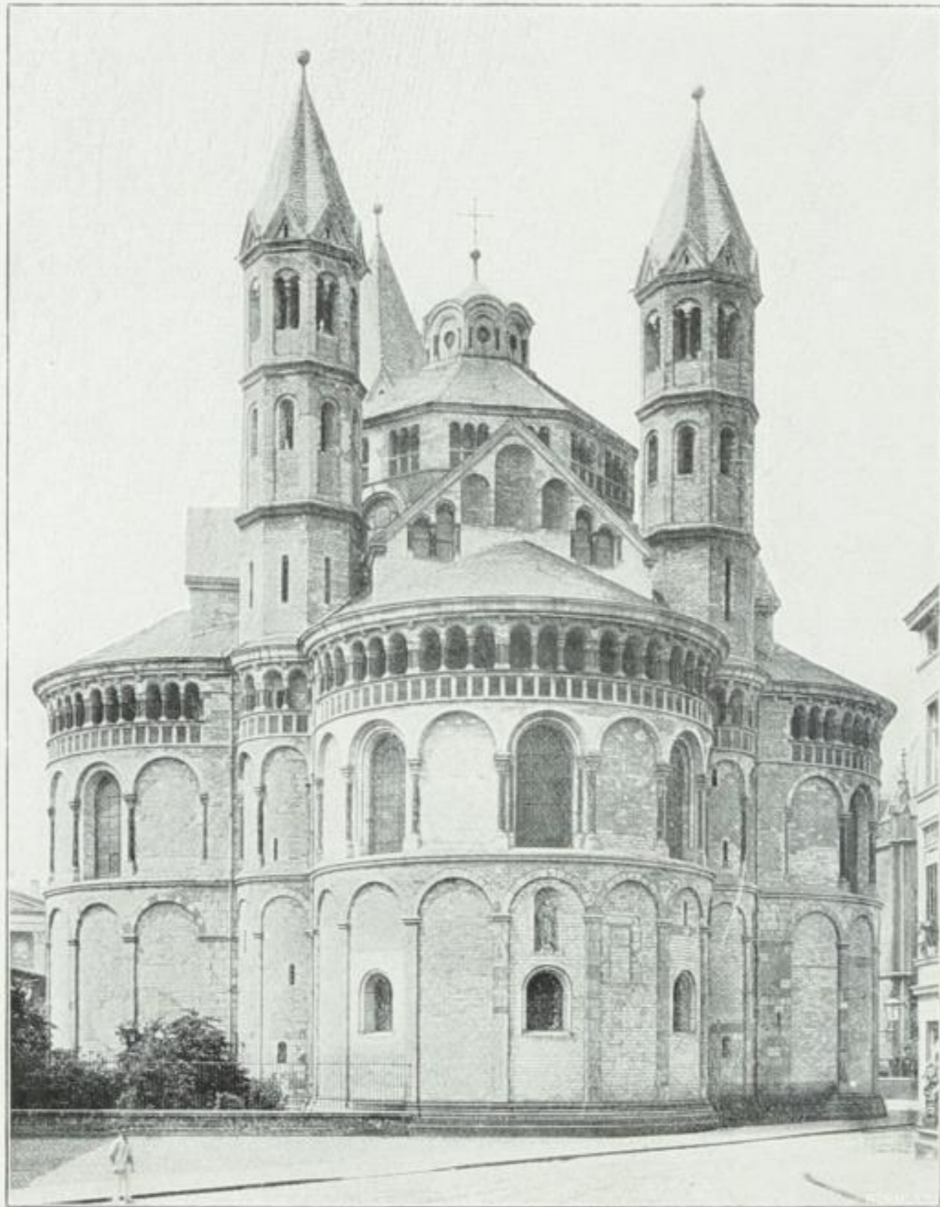
Fig. 40. Der Ostbau von St. Aposteln.
