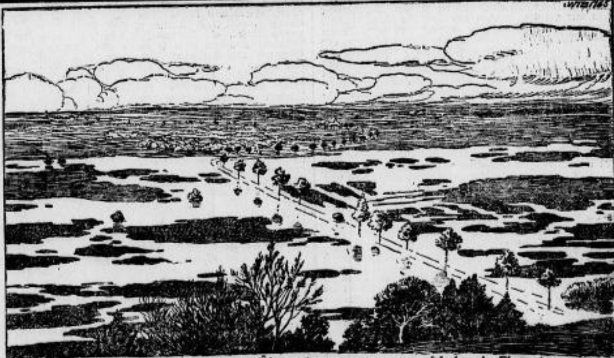
Blick auf einen Teil des Überschwemmungsgebietes in Flandern.
