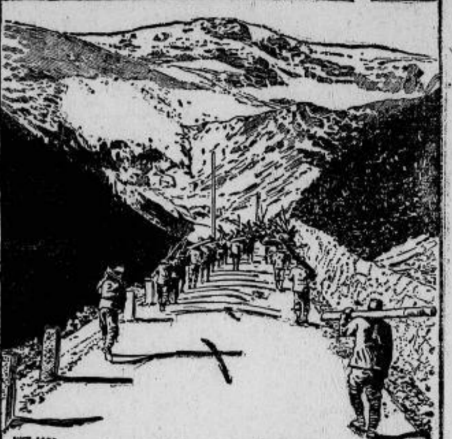
Befestigungsarbeiten am Stilser-Joch. Österreichische Soldaten tragen Baumstämme auf der Stilserjochstrasse nach der Passhöhe.
