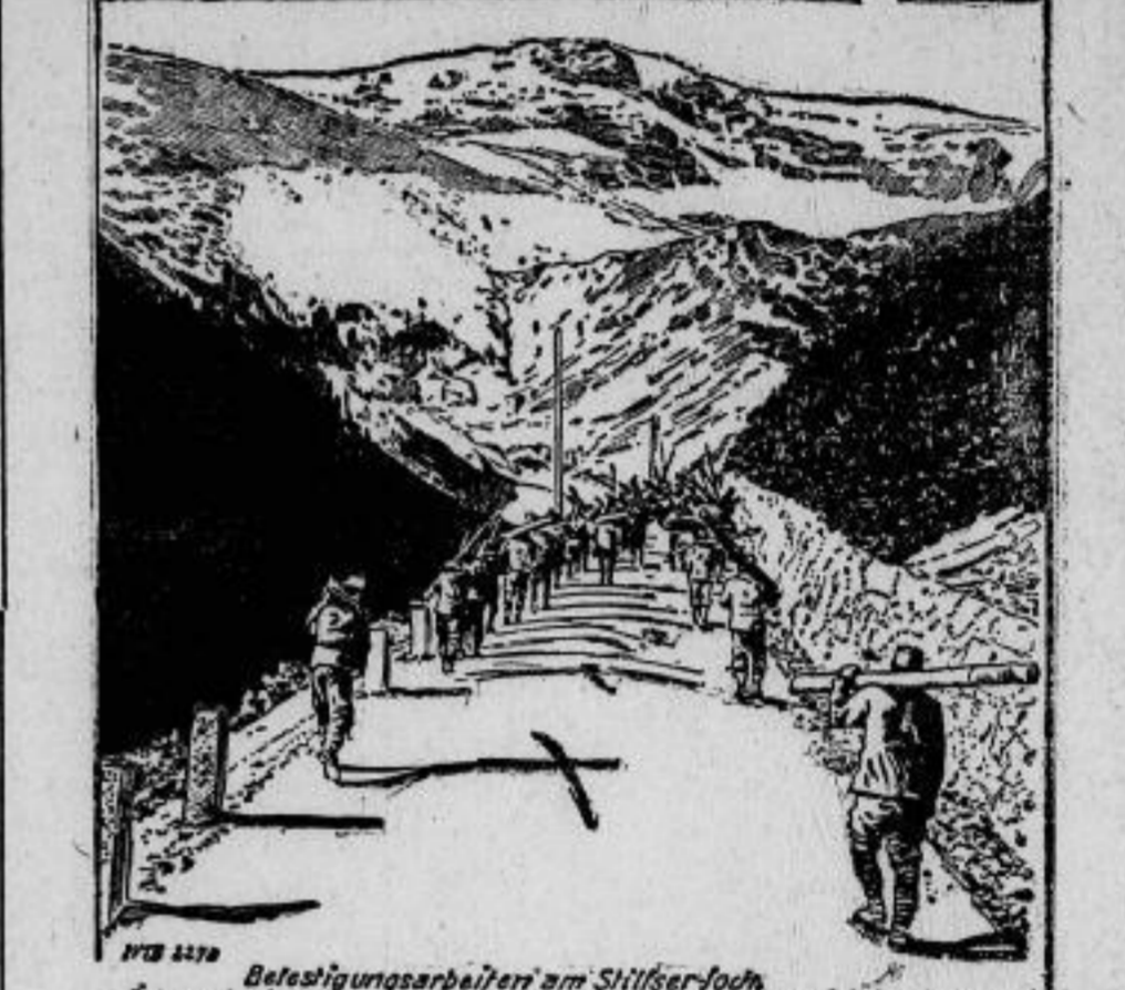
Befestigungsarbeiten am Stilser-Joch. Österreichische Soldaten tragen Baumstämme auf der Stilserjochstrasse nach der Passhöhe.
