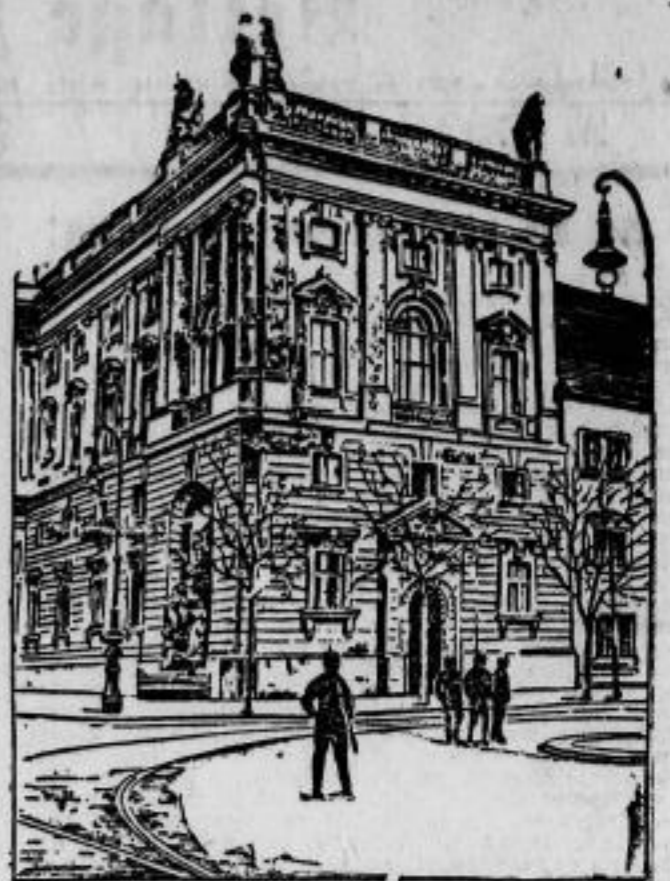
Das Marstallgebäude in Berlin mit den Spuren des Maschinengewehrfeuers.
