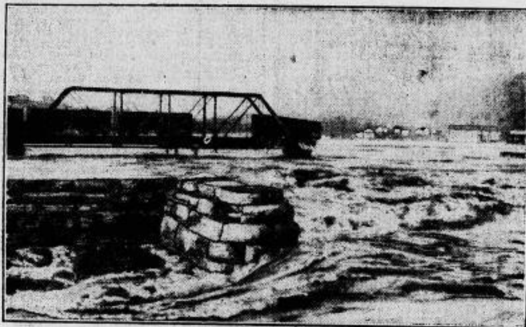
Uberschwemmungskatastrophe in Amerika. Eine von den Fluten fortgerissene Brücke in Baltimore, worauf sich gerade ein Witterzug befand. Die eine Hälfte der Brücke verlor mit den Waggons sofort in den Fluten.
