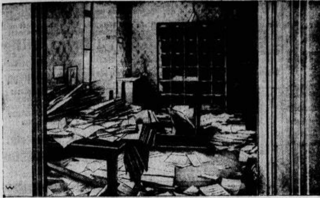
Das demolierte Berncasteler Finanzamt.
