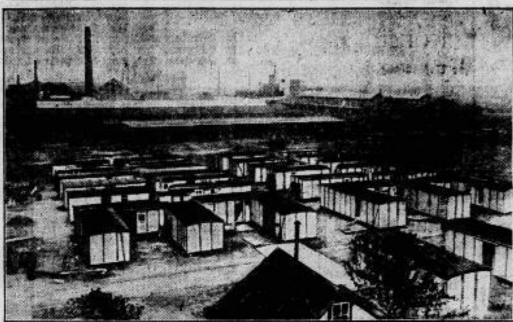
Ein Zeichen der großen Wohnungsnot. Eine Wohnkolonie aus Eisenbahnwaggons in Hannover. Um der dringenden Wohnungsnot zu steuern, hat die Stadt Hannover eine Reihe alter Eisenbahnwaggons versuchsweise zu Wohnungszwecken einrichten lassen. Dadurch sind Wohngelegenheiten entstanden, die den Vergleichen mit vielen alten Stadtwohnungen reichlich ausreichen. Sie sind luftig, hygienisch einwandfrei und gesund. Durch zweckmäßige Einrichtung sowie freundlichen Anstrich und geordneten Zusammenbau gibt die Siedlung, die richtige Straßenzüge und Höfe hat, ein nettes Gesamtbild.
