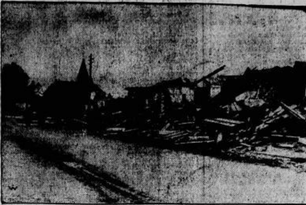
Die Hauptstraße des Dorfes mit den vollständig eingeebneten Häusern. Nur die gänzlich aus Steinen erbaute Kirche blieb unverlezt.
