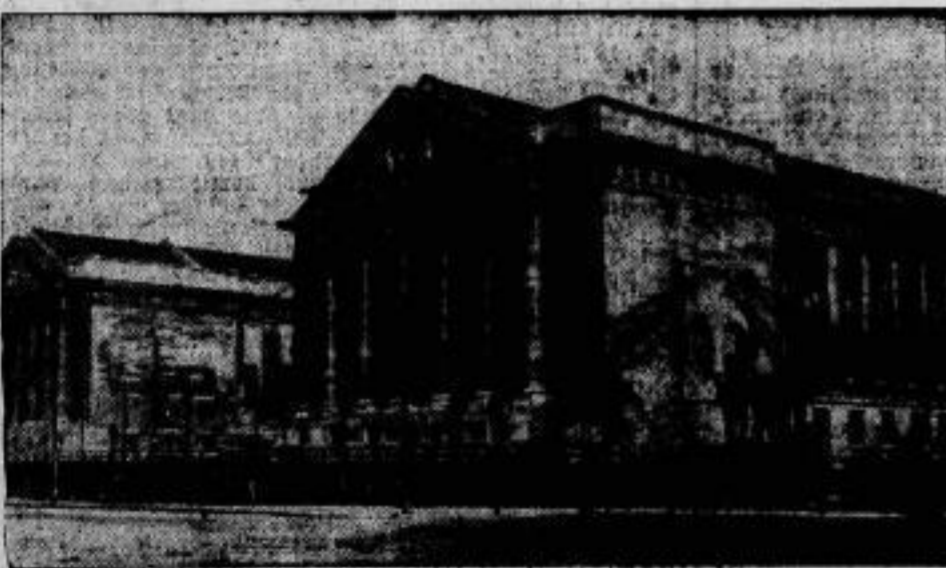
Das neue „Deutsche Museum“ in Berlin. Nach Beendigung der Besprechungen zwischen Wilhelm v. Bode und Geh. Rat Hoffmann, sind die Bauarbeiten am „Deutschen Museum“, im wesentlichen unter Zugrundelegung des alten Bauplans von 1914, wieder aufgenommen worden. Das Museum soll in erster Linie die ältere deutsche Kunst aufnehmen.
