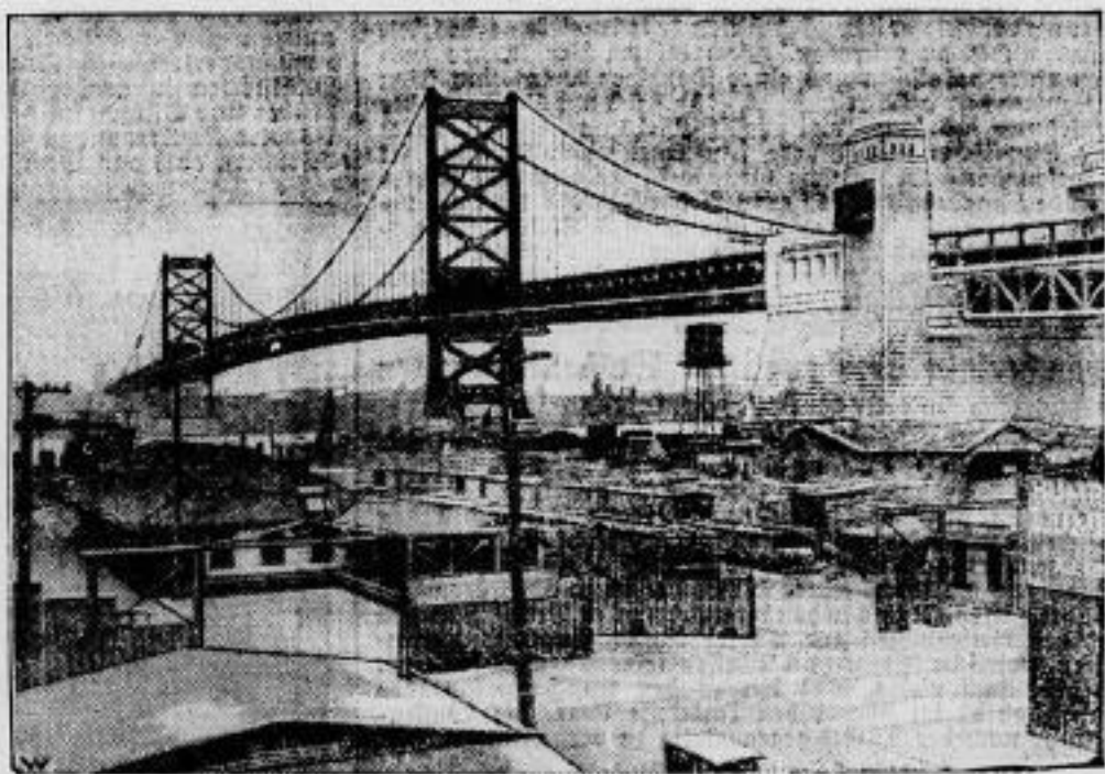
Die größte Hängebrücke der Welt. Der Bau der Camden-Whiladelphia-Brücke, der größten Hängebrücke der Welt, ist beendet. Sie überspannt den Delaware-Fluß und verbindet die Staaten Pennsylvania und New Jersey.
