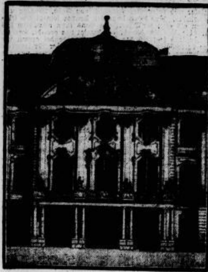
Schöne barocke Fassade. — Gebäude aus dem Barock. Kurfürstliches Palais in Trier.
