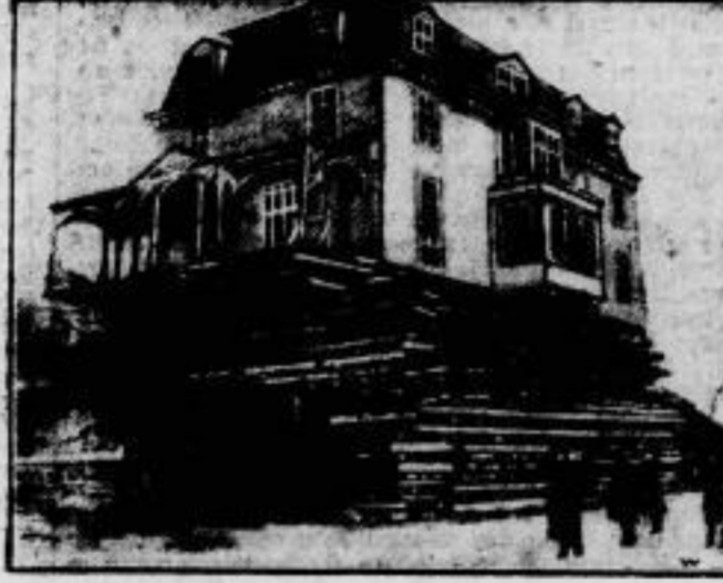
Im Lande der unbegrenzten Möglichkeiten! Aufstuden von unten. Ein fündiger amerikanischer Architekt kam durch ausführliche Berechnung dahinter, daß das Aufstuden von Häusern wesentlich billiger ist, wenn die neuen Stadwerke unter den schon bestehenden gebaut würden. Zunächst wurde dies neue Verfahren bei einem kleinen Hause ausprobiert und der Versuch glückte so vollkommen, daß er heute schon sehr viele Aufträge auf diese neue Bauart erhalten hat. Auf unserem Bilde sehen wir das mittels Balkenstuhl gebundene Haus, unter dem dann der Neubau beginnt.
