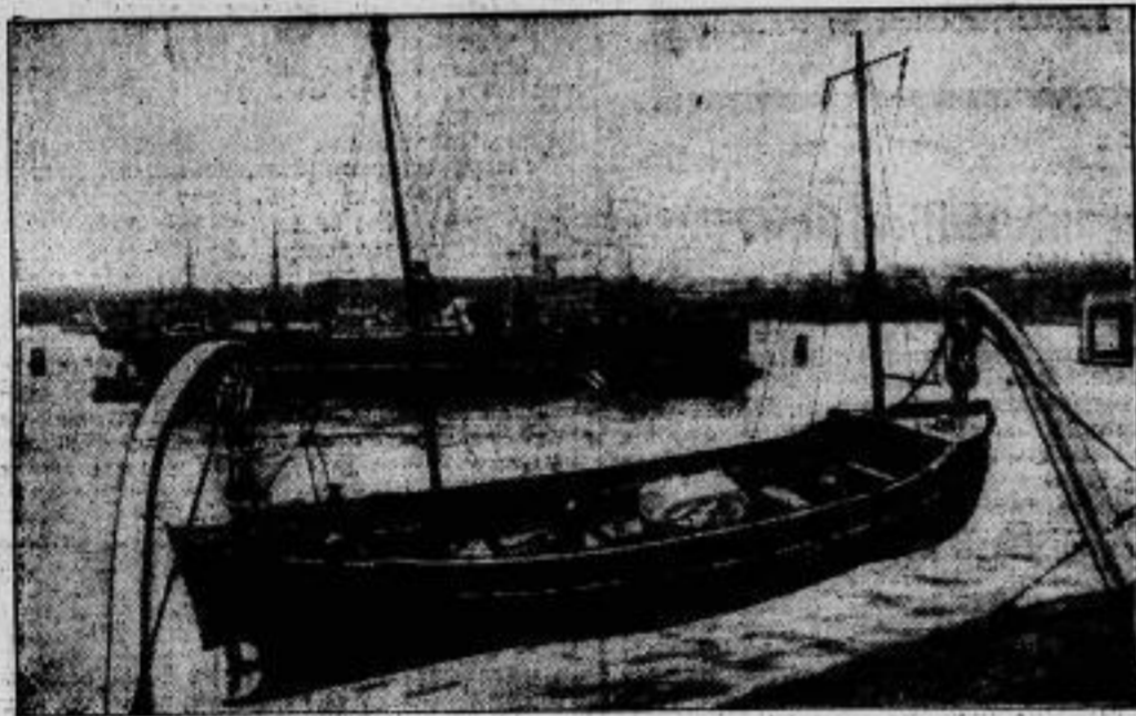
Retungsboote mit Motorantrieb und drahtloser Telegraphanlage. Auf den großen Passagierdampfern der Hamburg-Amerikaliner werden jetzt Rettungsboote mit Motorantrieb eingeführt, die mit einer F. T. Anlage ausgerüstet sind, sodass bei Unglücksfällen die Rettungsboote funktentelegraphisch Hilfe herbeizufordern können. — Unser Bild zeigt solch modernes Rettungsboot auf dem Dampfer „Albert Ballin“.
