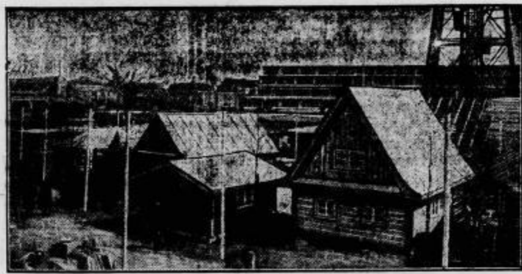
Die entzückende Wochenend-Ausstellung. Beim Aufbau der Wochenend-Häuschen. Die mit großem Interesse erwartete „Wochenend-Ausstellung“ in Berlin, die bekanntlich der Propagierung des Gedankens der „Week-end“-Einrichtung dienen soll, wird am Osterionabend eröffnet.
