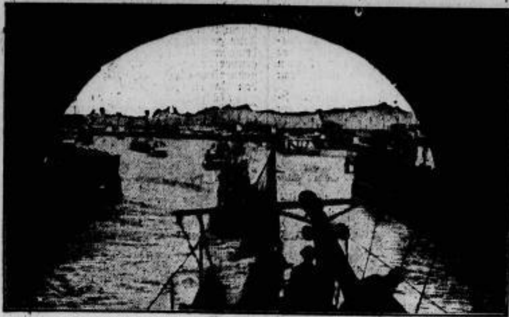
Ein Kanaltunnel bei Marzelle.
