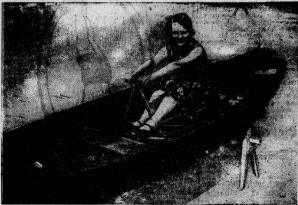
Neues von der dreijährigen Leipziger Herbstmesse. Das Ruderboot der Zukunft. Durch Hebelantrieb wird mit den Händen mit wenig Kraft eine Schraube in Bewegung gesetzt, die das Boot antreibt. Der Ruderer sitzt in Fahrtrichtung, Steuerung durch Fußpedal.
