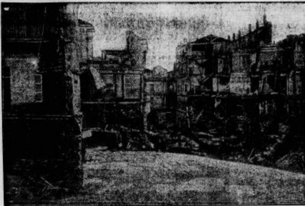
Ueberschwemmungskatastrophe in Maler. Der Gambetta-Platz in Moskau, das durch das Anschwellen des tin Sestra in einen wüsten Trümmerhaufen verwandelt wurde.
