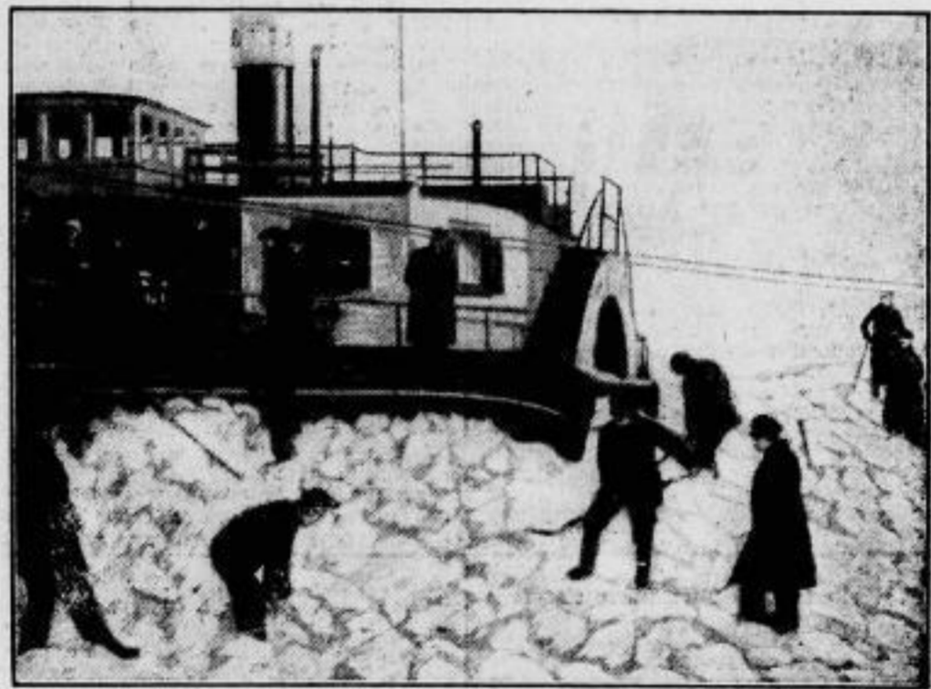
Schwerer Eisgang auf der Donau.
