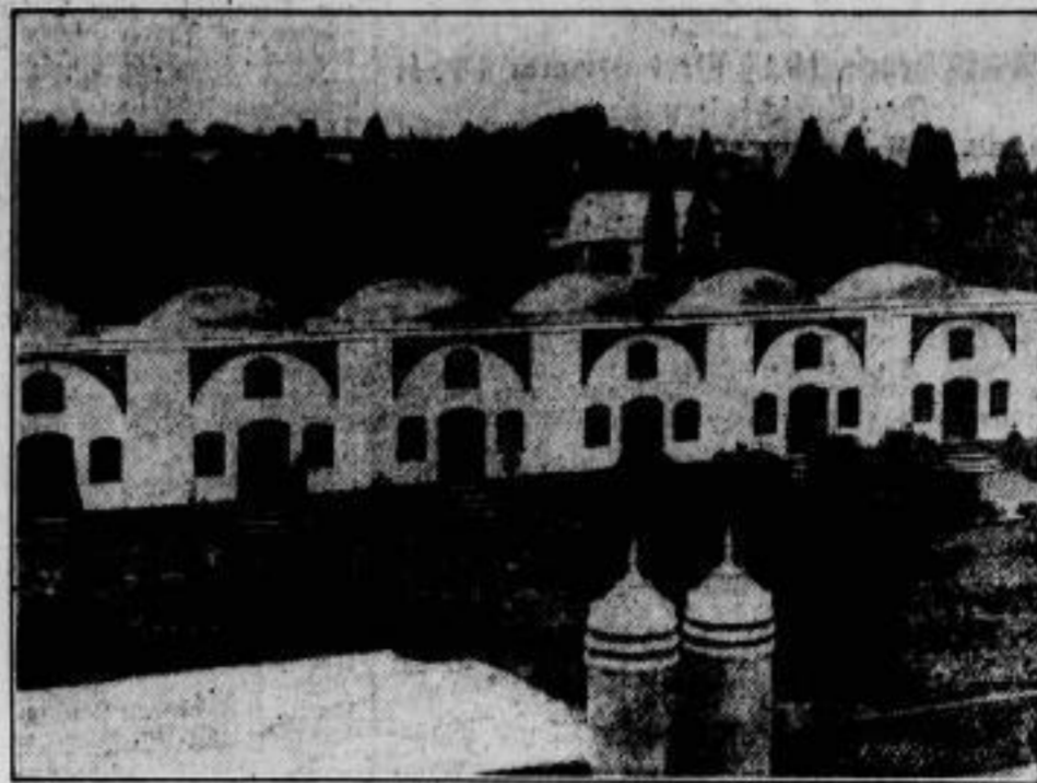
Die Afghanisten des Wohnungsproblems löst. Der König von Afghanistan hält sich zur Zeit in Europa auf. Unter Bild zeigt eine Reihe Neubauten in Djelal-Abad, der Winterhauptstadt Afghanistans.
