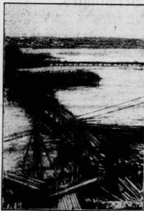
Die erste Eisenbahnverbindung von Sibirien nach Turkestan. Brückenbau über den Syr Darya
