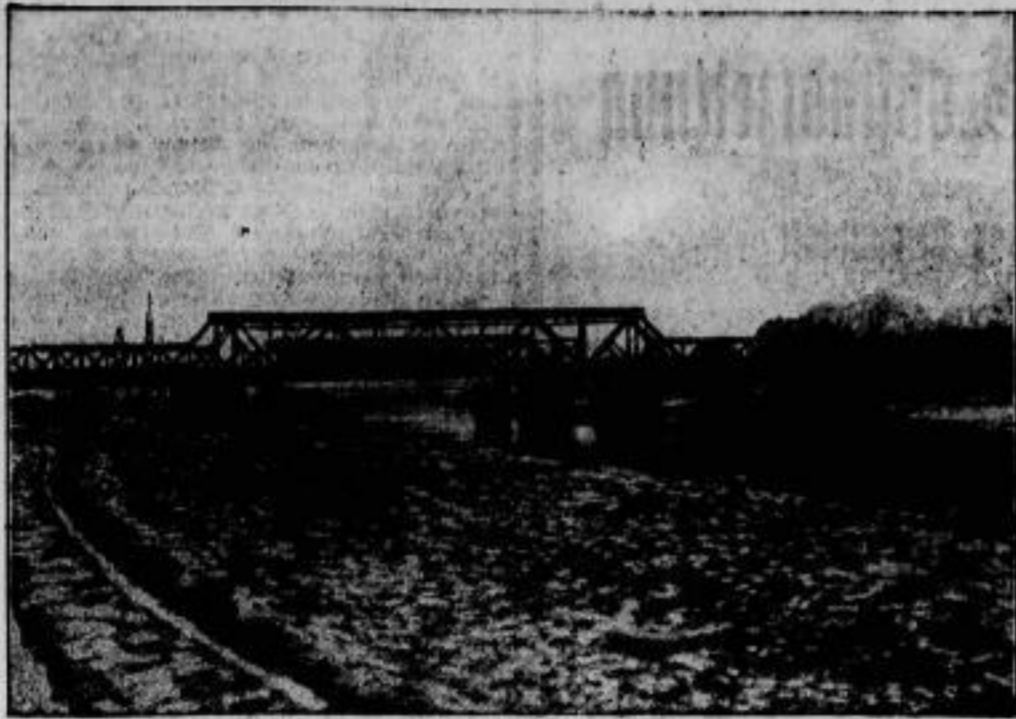
Die neue Eisenbahnbrücke über die Ober bei Coblenz.
