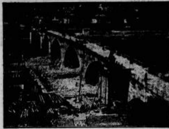
Trockenlegung der alten Heidelberger Karl-Theodor-Brücke wegen Tieferlegung des Flussbettes für den Neckarkanal.
