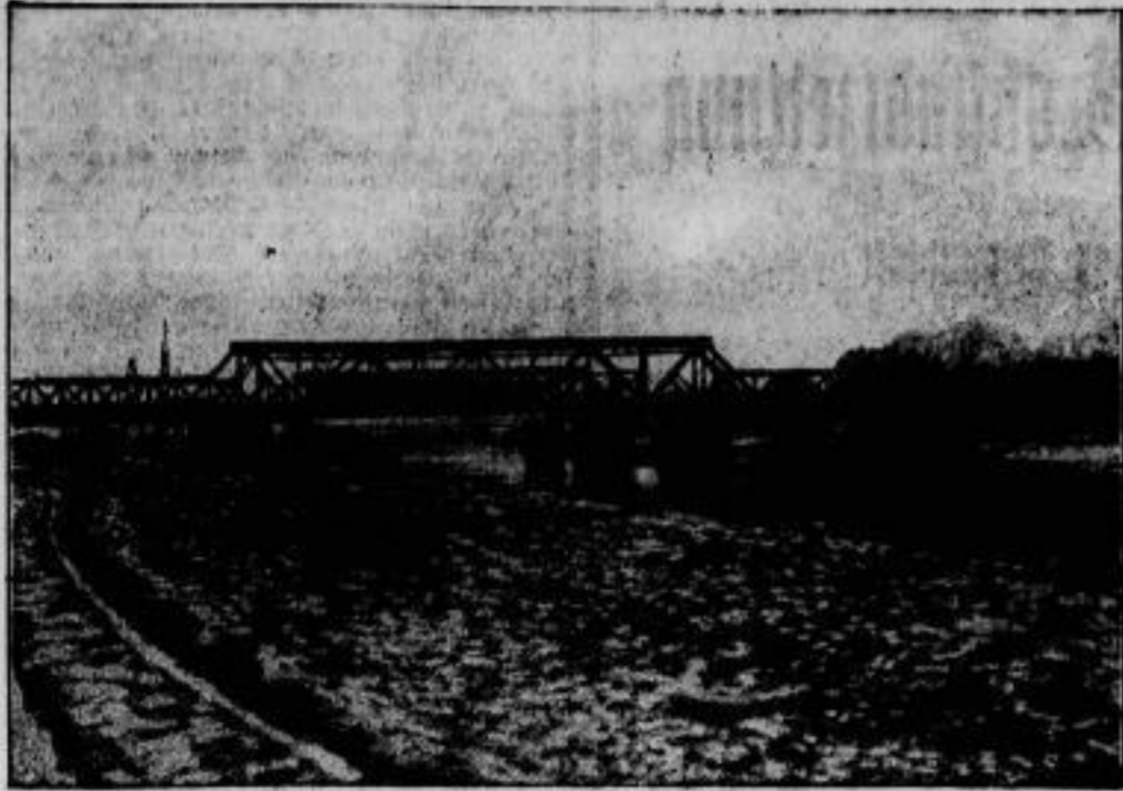
Die neue Eisenbahnbrücke über die Oder bei Cypeln.
