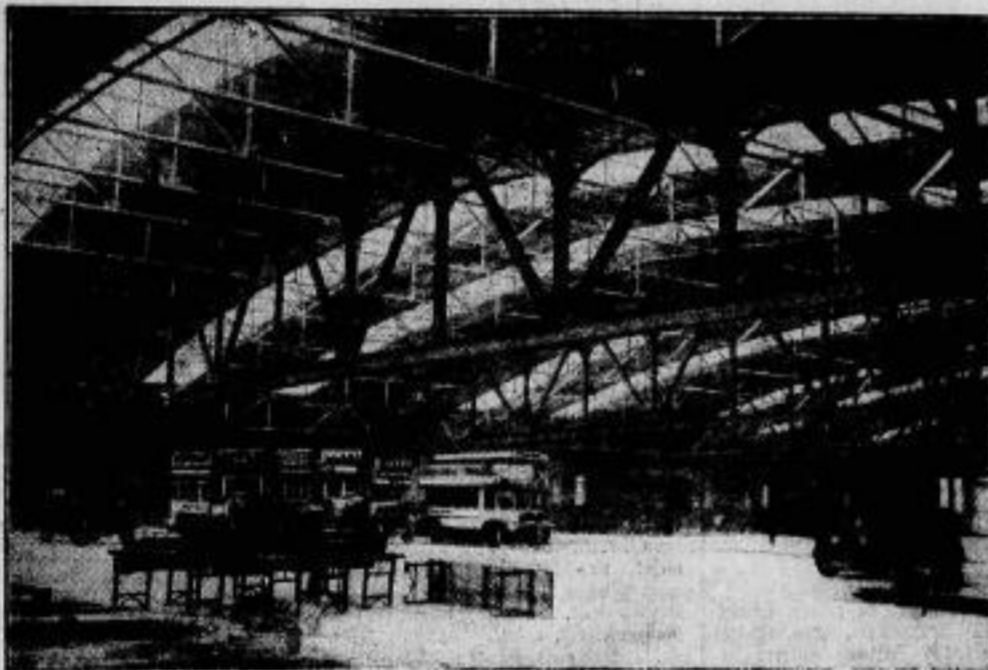
Die größte Autobushalle der Welt Die neue Großgarage der Abwaag, Berlin Die Abwaag (Allgemeine Berliner Omnibusgesellschaft) hat soden ihre neue Großgarage in Berlin-Treptow in Betrieb genommen, die als die größte und modernste Garage der Welt bezeichnet werden kann. Es ist ein einziger, völlig stützenfreier Raum von 70 Meter Breite und 100 Meter Länge, der 160 Omnibussen Raum bietet. Das Dach wird von vier 70 Meter weitgespannten riesigen Fachwerkbalken getragen, von denen jeder über 100 Tonnen wiegt.
