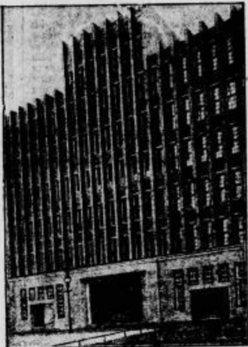
Moderne Zweckbauten in der alten Hansestadt Hamburg. Das Gesundheitsamt.
