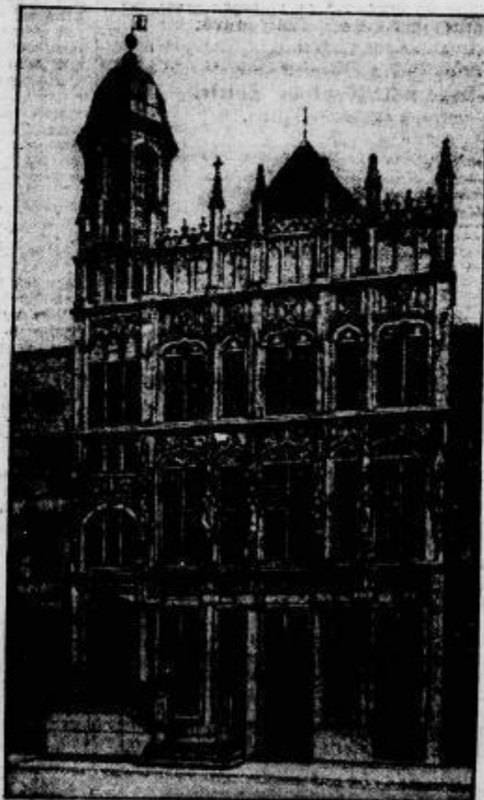
Schöne deutsche Bauten. Das Kaiserpalast in Berlin, das 1890-1896 erbaut wurde. Die jetzige Fassade entstand ein Jahrhundert später.
