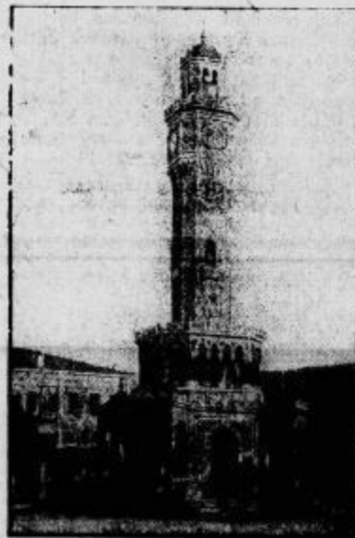
Schweres Erdbeben in Anatolien. Smyrna und seine Umgebung wurden am 21. März durch ein schweres Erdbeben heimgesucht. Zahlreiche Gebäude stürzten ein. Bisher wurden über hundert Tote gemeldet. — Unser Bild zeigt den berühmten Uhrturm in Smyrna, der ebenfalls dem Erdbeben zum Opfer fiel.
