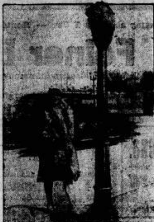
Jeder sein eigener Verkehrszeichenmann. In Los Angeles (Kalifornien) hat man an verkehrsreichen Punkten Verkehrszeichen aufgestellt, die vom Passanten selbst bedient werden können. Wird die Ueberquerung der Straße durch den Wagenverkehr unzulässig gemacht, so schaltet man durch Druck auf einen Knopf ein rotes Signallicht ein, das die Straße sperrt. Gleichzeitig wird der Uebergang hell beleuchtet.
