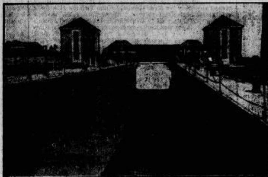
Der Bau des Mittellandkanals schreitet vorwärts. Mit der Fertigstellung der oben abgebildeten Kanalschleuse vor Anderten bei Vehrte, an der mehrere Jahre gearbeitet wurde, ist eine wichtige Etappe im Gesamtbau des Mittellandkanals abgeschlossen worden. Diese Schleuse, die bereits mit Wasser gefüllt wurde, ist die größte Binnenwasser Deutschlands.
