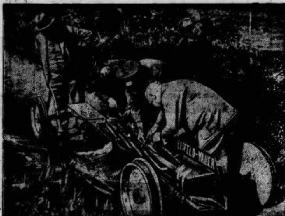
Neuer Versuch mit Raketenwagen. Am 26. Juli machte auf der Eisenbahnstrecke Nordhausen—Gernrode der von Wallier unabhängig von Opel konstruierte Raketenwagen „Eisfeld-Wallier Nat. 1“ seine ersten Versuchsfahrten. Der Wagen unterscheidet sich von dem Opel'schen Modell dadurch, daß er aus Holz konstruiert ist und daß die Raketen über den ganzen Wagen verteilt sind. Die erste und zweite Fahrt erreichte bei halber Raketenladung eine Stundengeschwindigkeit von 180 Kilometern. Bei der dritten Fahrt, die mit voller Ladung unternommen wurde, erzielte der Wagen eine Geschwindigkeit von 210 Kilometern, wurde dann aber in einer Kurve aus den Schienen geworfen und vollkommen zertrümmert. In einigen Wochen wird Wallier mit einem neuen Wagen aus Leichtmetall seine Versuche wiederholen. — Im Bilde: das Anbringen der Raketen an dem früher verunglückten Wagen.
