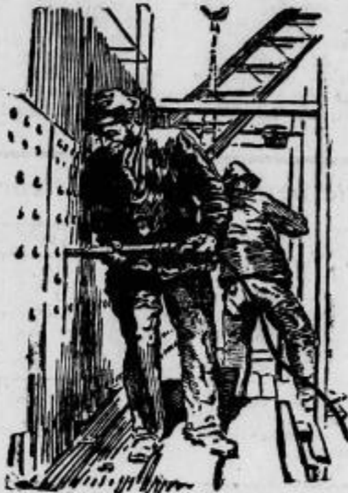
Ritzen an der Außenhaut mit Proflußhämmern
