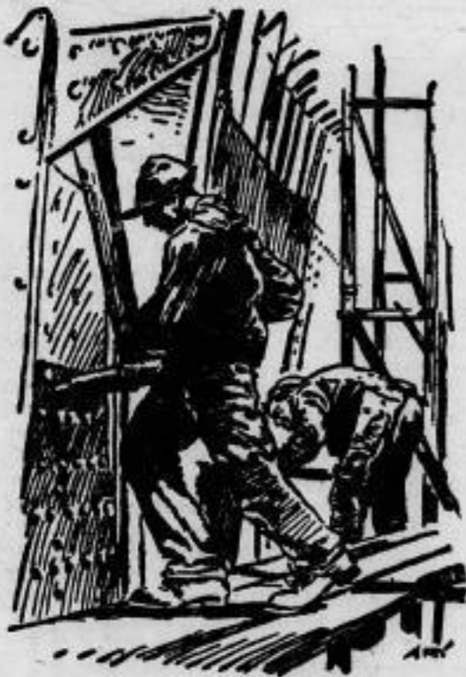
Der Vorhalter der Ritzkolonne im Innern des Schiffes bei der Ritzung der Außenhaut.
