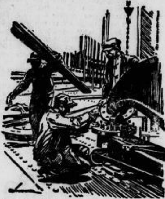
Der Großzylinder der Ritzgange wird geprüft.
