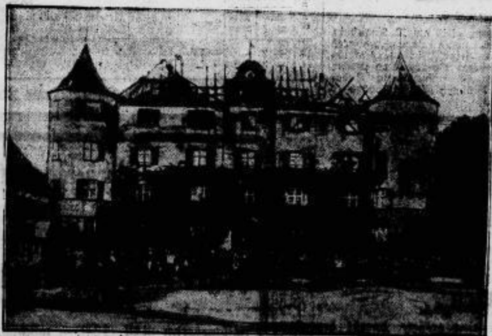
Ein historisches Schloß niedergebrannt. Das aus dem 15. Jahrhundert kommende Schloß Feilzingen an der Bahnlinie Augsburg-Rürnberg, das dem Grafen Schenk von Stauffenberg gehört, ist in der Nacht vom 11. zum 12. August durch ein Großfeuer gänzlich zerstört worden. Namentlich ist der Wert der sehr wertvollen alten Mobiliars und einer umfangreichen Bibliothek zu beklagen.
