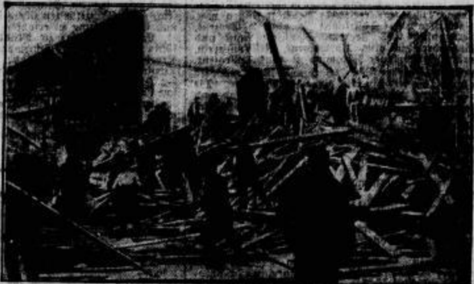
Naß der Trümmerstätte des Prager Hausbesitzeres. Die Rettungsarbeiten, die unser Bild zeigt, gehen infolge des Hailgewitters und der zu einer kompakten Masse zusammengedrückt Betontrümmer nur langsam voran.
