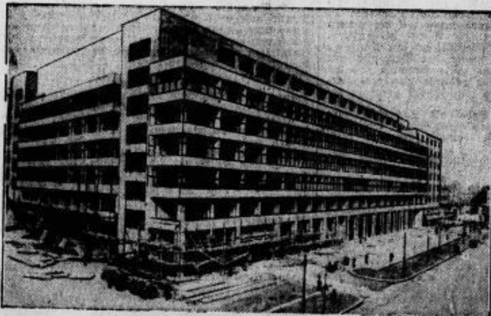
Das größte Hochgebäude der Welt wird zurzeit in Prag gebaut. Das Gebäude, das kürzlich im Rohbau fertiggestellt wurde, bietet Raum für 60.000 Personen. Es wird hauptsächlich den Zwecken der Messen dienen.
